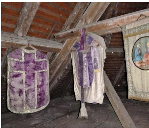
Ungeschützte Paramente im Dachraum
