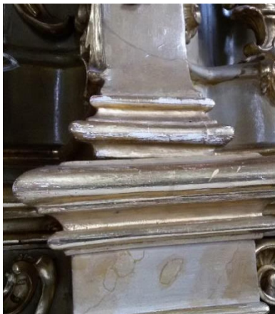
Abrieb der Blattmetallauflagen durch heftiges Putzen
