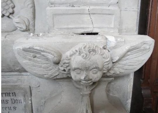
Steinepitaph mit durch Schubkräfte verursachten Rissen und Abplatzungen
