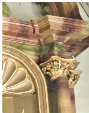
Gelöste und instabile Verbindung am Altar
