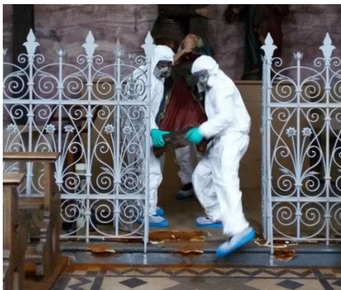
Hausschwammbefall an hölzerner Ausstattung
