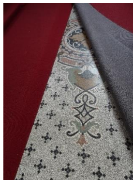
Verdeckter historischer Terrazzoboden
